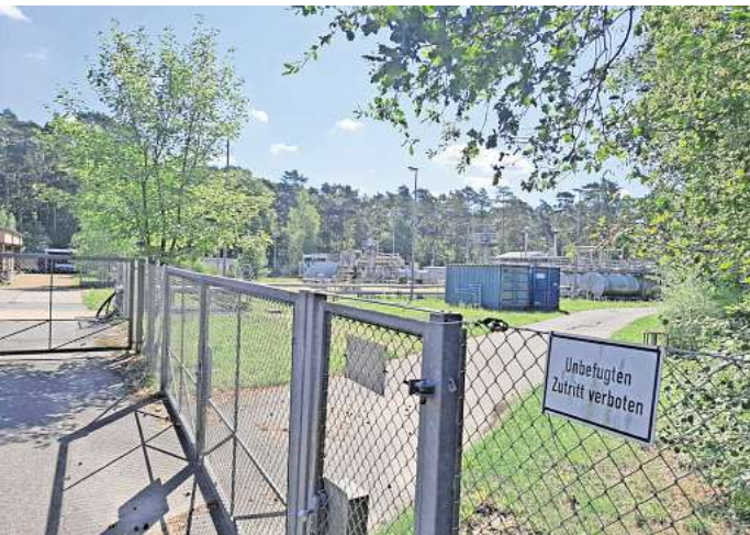
Neuer Betreiber: Förderanlage des Erdgasfelds bei Burgwedel-Thönse. Foto: Frank Walter
