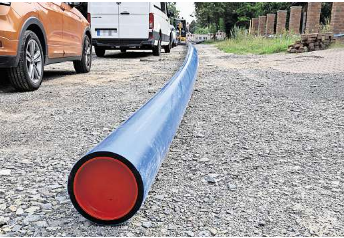
Lange Rohre: Im dritten Bauabschnitt der K113 werden gerade Wasserleitungen erneuert. Foto: Frank Walter
