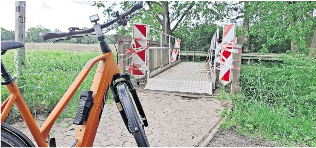
Noch mit Brückenprovisorium über die Edder: Der Weg zwischen Lohne und Kirchhorst soll Laternen erhalten.
