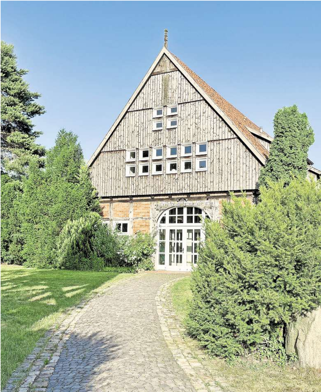
Das Haus der Kirche am Moorweg in Kleinburgwedel – in Eigenleistung erbaut, seit 45 Jahren ein Ort der Begegnung und des Miteinanders. Foto: Birgit Schröder
