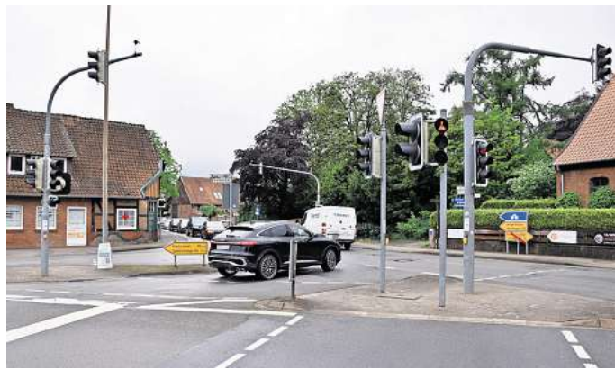
Wird bei der Sanierung umgestaltet: Der Abzweig nach Isernhagen-Süd. Foto: Frank Walter
