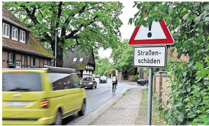
Soll als erster Bauabschnitt der L381 saniert werden: die Straße Am Ortfelde in Isernhagen N.B. Foto: Frank Walter
