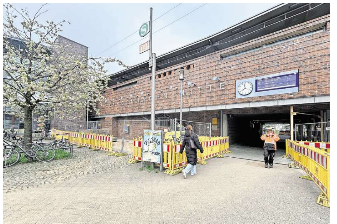
Umstieg zwischen S-Bahn und Ersatzbus: Am Bahnhof Langenhagen-Mitte beginnen und enden die Fahrten nach Isernhagen und Großburgwedel.
