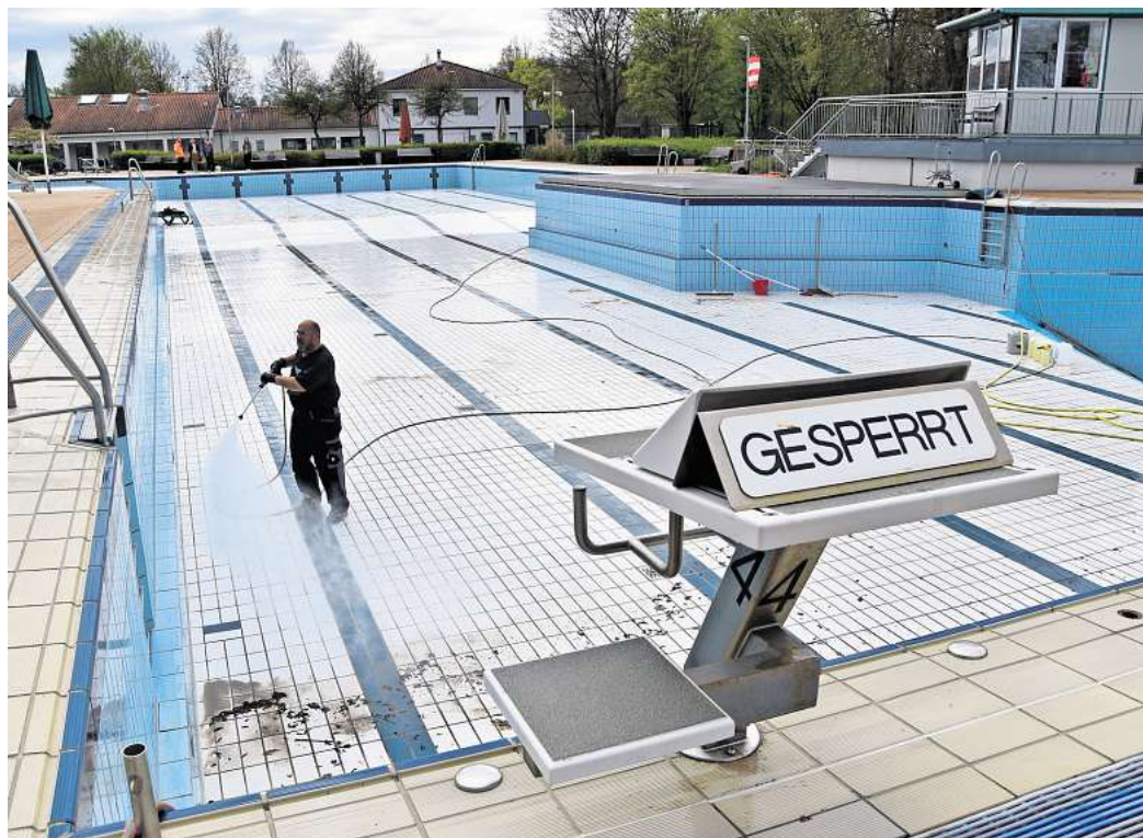
Vor dem Wassereinlass steht die Reinigung an: Alexander Serebrennikov säubert den Beckengrund mit einem Hochdruckreiniger. Foto: Frank Walter
