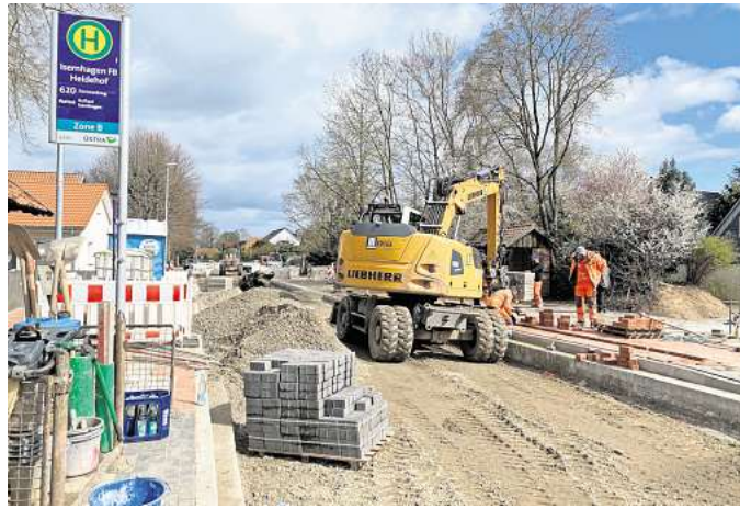
Letzte Arbeiten vor den Osterfeiertagen: Arbeiter pflastern den Gehweg an der K113 in F.B. Foto: Katerina Jarolim-Vorheimer
