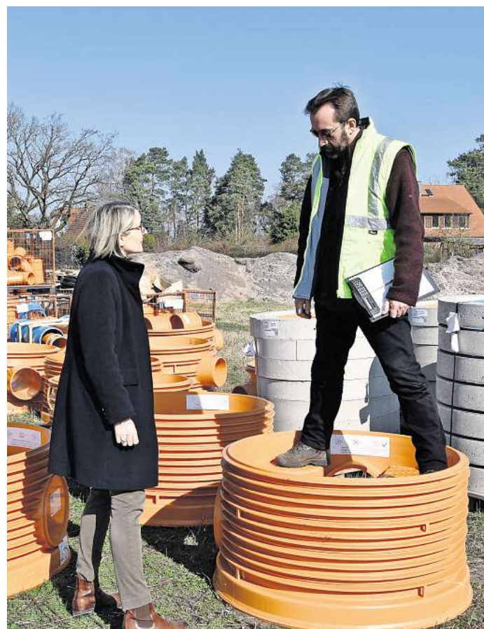
Riesig und orange: Tiefbau-Teamleiter Alexej Wyshimok zeigt Bürgermeisterin Ortrud Wendt (CDU) in Fuhrberg einen der Schmutzwasserschächte für das Neubaugebiet. Foto: Frank Walter
