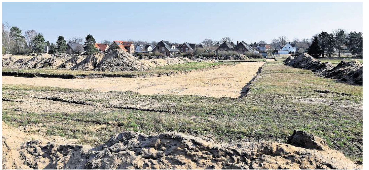
Der künftige Straßenverlauf ist schon zu erkennen: das Baugebiet "Südlich Glockenberg" in Wettmar.
