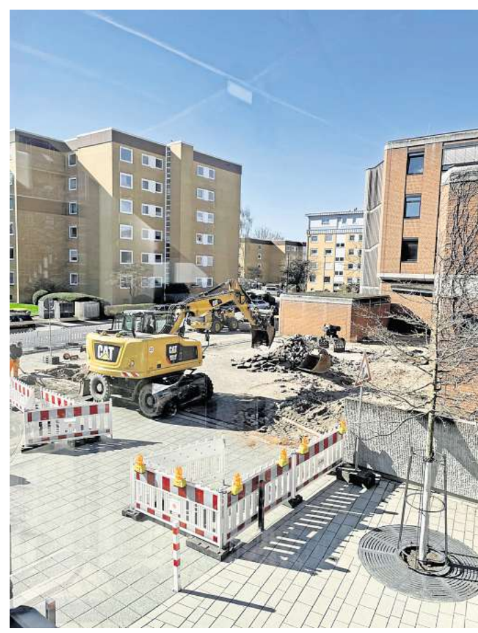
Die Arbeiten für den fünften Bauabschnitt der Städtebaufördermaßnahme „Zentrum Isernhagen“ in der Stettiner Straße haben begonnen. Foto: Svenja Theunert/Gemeinde Isernhagen
