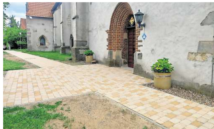
Die neue Pflasterung im Außenbereich der St. Marienkirche Isernhagen. Foto: Grunewaldt-Stöcker, Stiftung St. Marien Isernhagen
