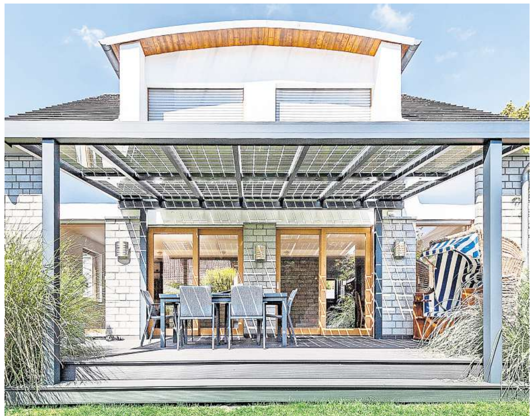
Mit einer designstarken Solarterrasse profitieren private Immobilienbesitzer einerseits von einer hochwertigen und ästhetischen Beschattungslösung, erreichen andererseits aber auch mehr Unabhängigkeit vom Versorger und dessen dynamischer Preisgestaltung. Foto: HLC/Solarterrassen & Carportwerk GmbH
