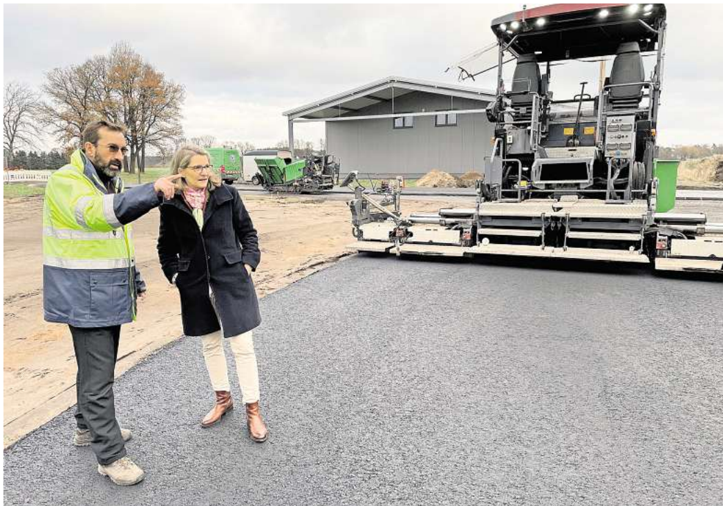
Bürgermeisterin Ortrud Wendt und Alexej Wyshimok begutachten den Fortschritt im Gewerbegebiet III. Foto: Stadt Burgwedel
