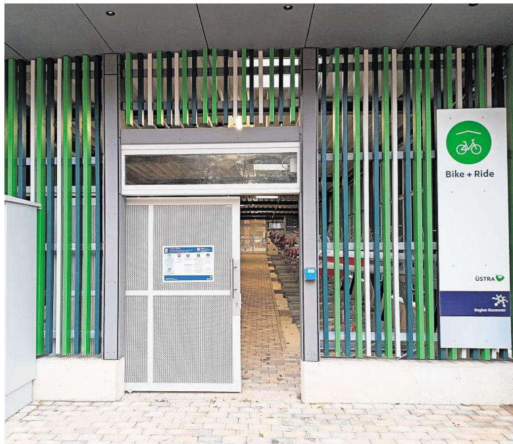
Die neue Bike-&-Ride-Anlage am Bahnhof Großburgwedel kann ab sofort genutzt werden.
