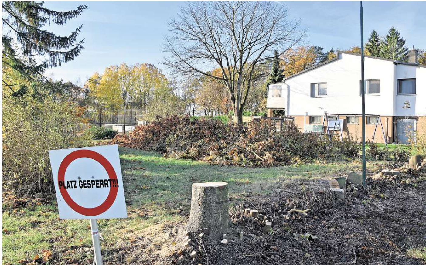
Die Bäume sind schon gefällt: Auf dieser Wiese neben dem Klubhaus (rechts) und den Tennisplätzen (hinten) soll der Mehrzweckplatz entstehen. Foto: Frank Walter
