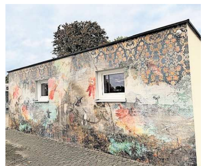
Die Fassadentapete zeichnet sich durch ihre besonderen Eigenschaften aus: Sie ist rissüberbrückend, wetterbeständig, abwaschbar und für den dauerhaften Einsatz im Außenbereich konzipiert.
