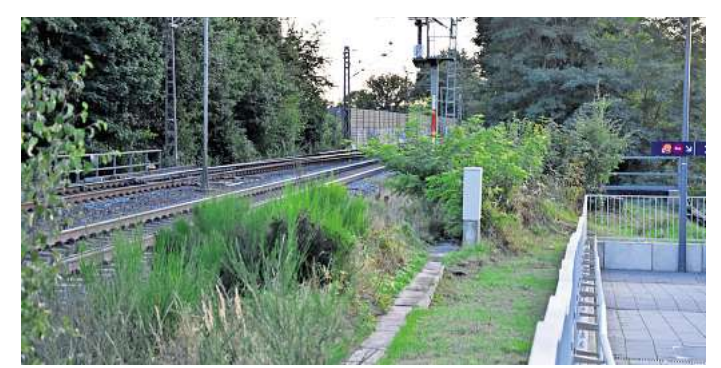
Zu kurz: Die Lärmschutzwand endet etliche Meter südwestlich des Bahnhofs Isernhagen H.B. und reicht in der anderen Richtung auch nur bis knapp vor den Försterstieg. Foto: Frank Walter
