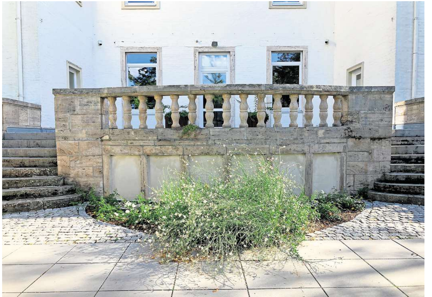
Die Terrasse: In den Räumen dahinter befinden sich derzeit noch Büros - bald soll dort der neue Trausaal entstehen.
