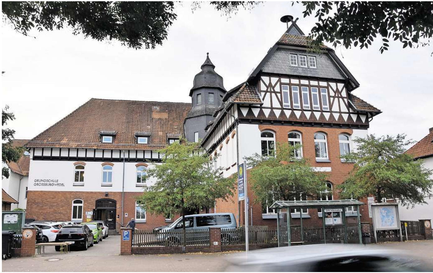
Erhält ein neues Dach: die Grundschule Großburgwedel.
