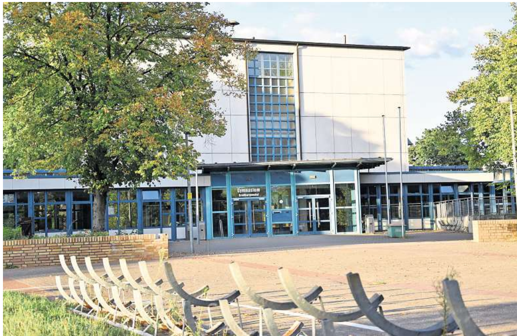
Wird größtenteils neu gebaut: das Gymnasium Großburgwedel. Foto: Frank Walter
