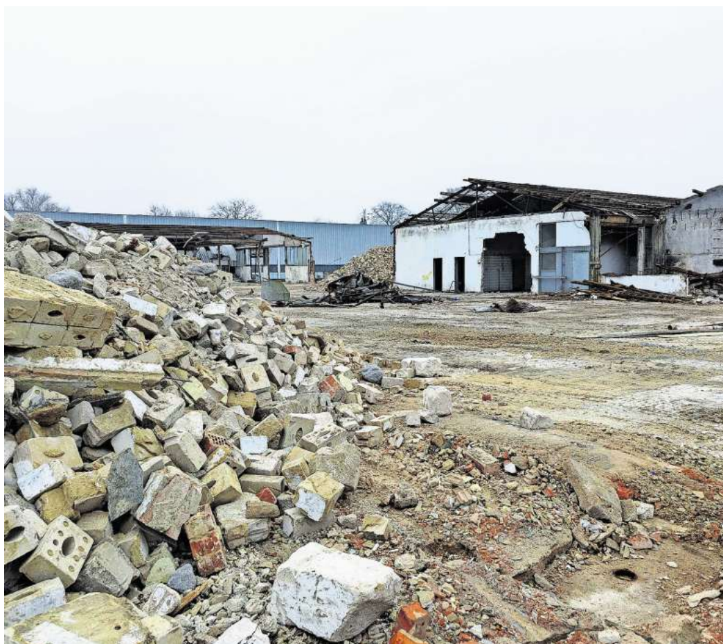
Anfang des Jahres wurde die Industriehalle in H.B. abgerissen und das Gelände für das Wohngebiet vorbereitet. Foto: Carina Bahl
