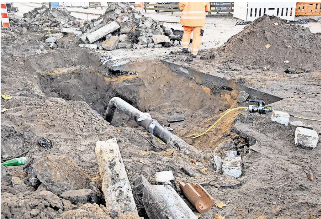
Die Schadensstelle: Arbeiter haben die Gasleitung in der Nacht geflickt.
