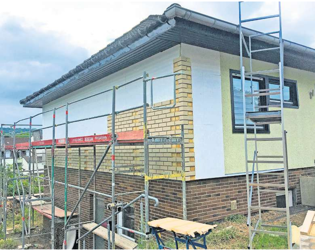
Eine Außendämmung mit Verklinkerung.
