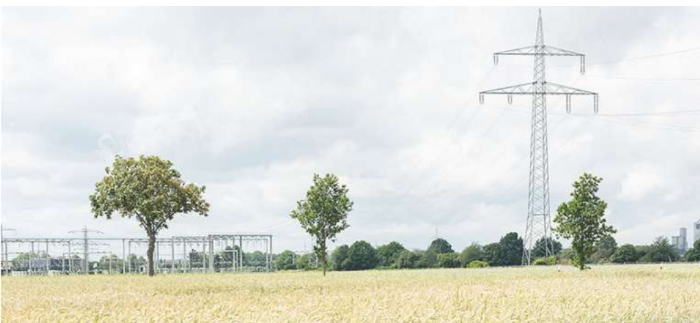
Freileitung zwischen Landesbergen und Lehrte: Mast 2 kurz vor dem Umspannwerk in Lehrte. Auf der rechten Seite (lange Isolatoren) wird die 220 kV-Leitung der TenneT geführt und auf der linken Seite (kurze Isolatoren) das 110 kV-System der Avacon.
