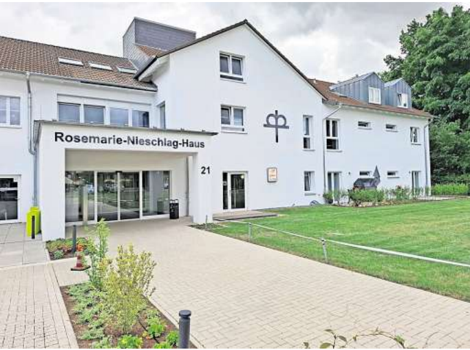
Der Eingangsbereich am Rosemarie-Nieschlag-Haus wurde umgestaltet. Foto: privat
