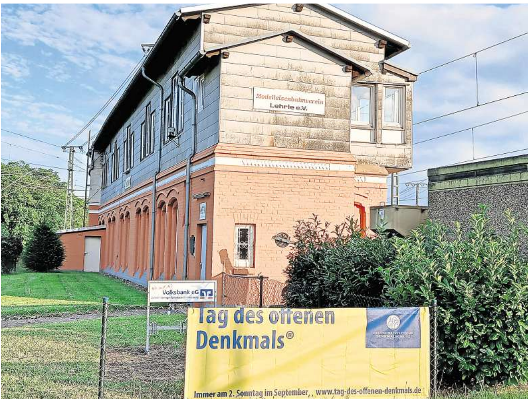
Besichtigung möglich: Das Museumsstellwerk an der Straße Richtersdorf.
