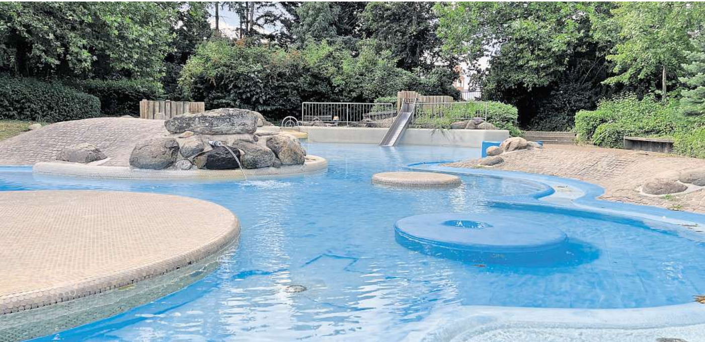
Frisch saniert: Das Planschbecken im Lehrter Freibad wurde vor Saisonstart neu gefliest und gestrichen.
