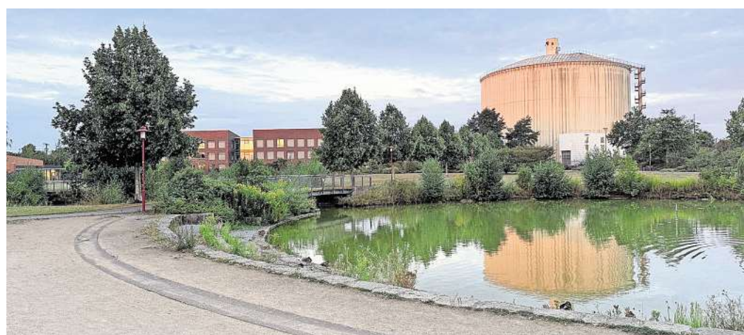
Regenrückhaltebecken im Hohnhorstpark.
