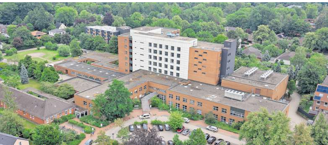
Sanierung und Neubau: Die Hahne-Gruppe möchte auf dem Lehrter Krankenhausgelände die Bestandsgebäude erhalten und verschiedenste Pflegeangebote integrieren. Ein wichtiger Bestandteil des Konzeptes ist auch der Neubau des RGZ durch das KRH auf dem Gelände. Foto: Tim Schaarschmidt
