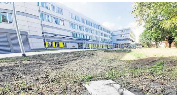
Gut für die Umwelt: In Regenwassermulden wird der Niederschlag aufgefangen und durch Versickerung dem Grundwasser zugeführt.
