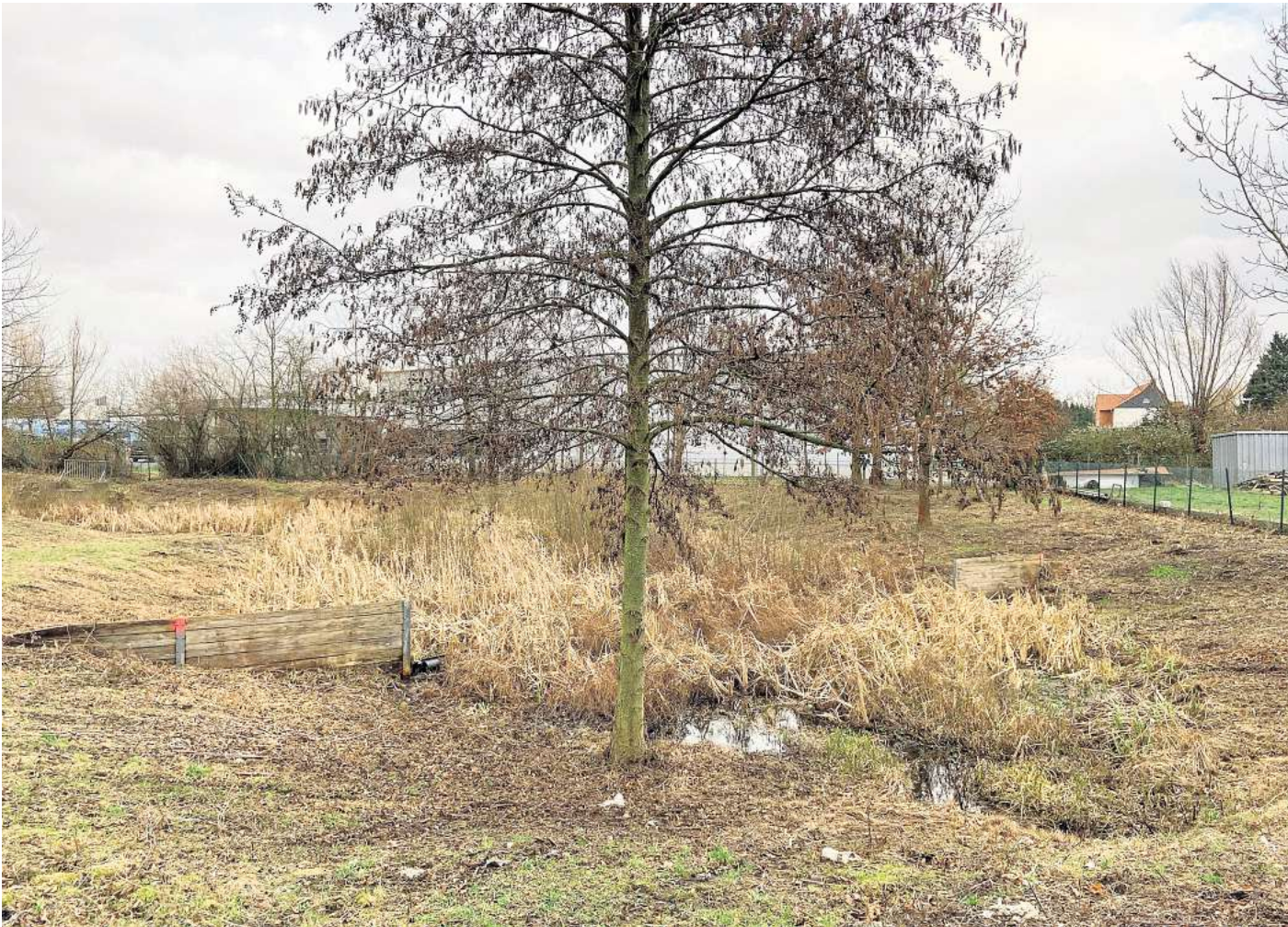
Das Regenrückhaltebecken Achardstraße soll erweitert werden.
