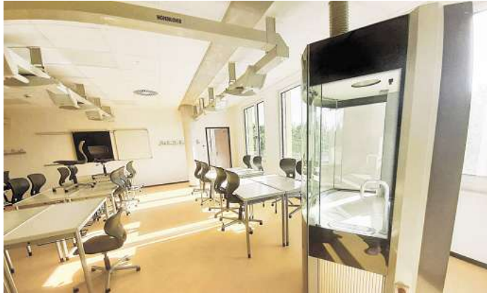
Zeit für Experimente: Ein Fachraum mit einem Digestorium (rechts), einem Laborabzug.
