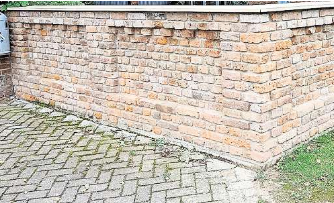
Mit Fördermitteln realisiert: Aufbau einer alten Mauer.
