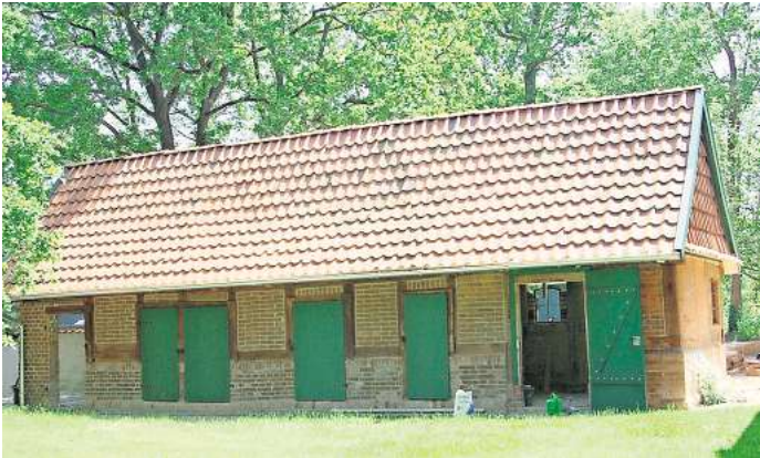
Der alte Hühnerstall dient nach der Instandsetzung als Abstellraum.
