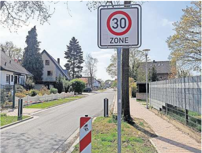
Mit Temporeduzierung und Fahrbahnverengung: Die Straße Vor dem Heeßel nach dem Ausbau. Foto: Stadt Lehrte
