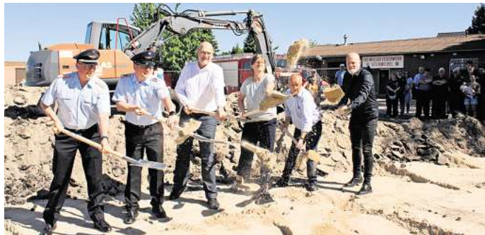
Endlich geht es los: Stadtbrandmeister Hendrik Voges (von links), Ortsbrandmeister Tobias Körner, Bürgermeister Frank Prübe (CDU), Stadtbaurätin Anja Hampe, Ortsbürgermeister Jens Utermann (SPD) und Sebastian Haumann vom Planungsbüro ASP Architekten schwingen den Spaten. Michael Schütz
