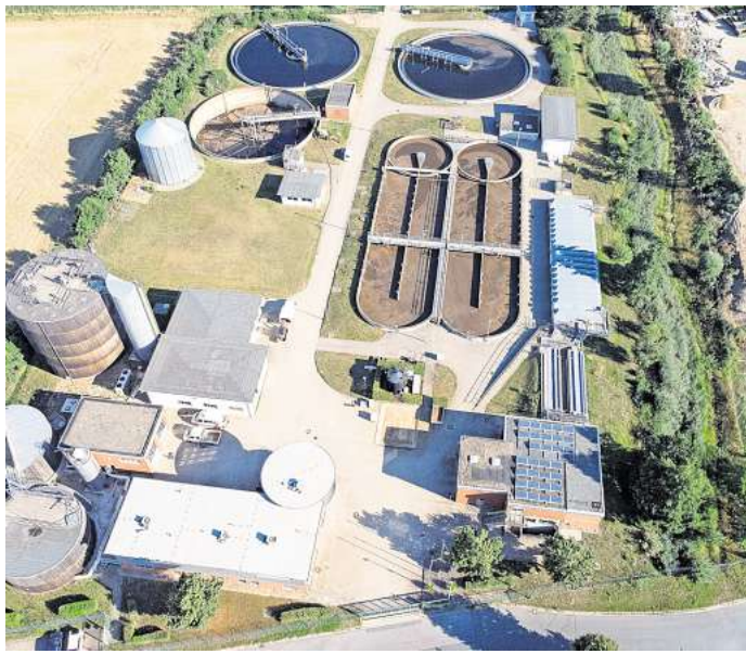
Kläranlage in Sehnde mit den verschiedenen technischen Bereichen zur Reinigung des Schmutzwassers. Foto: Joachim Lührs
