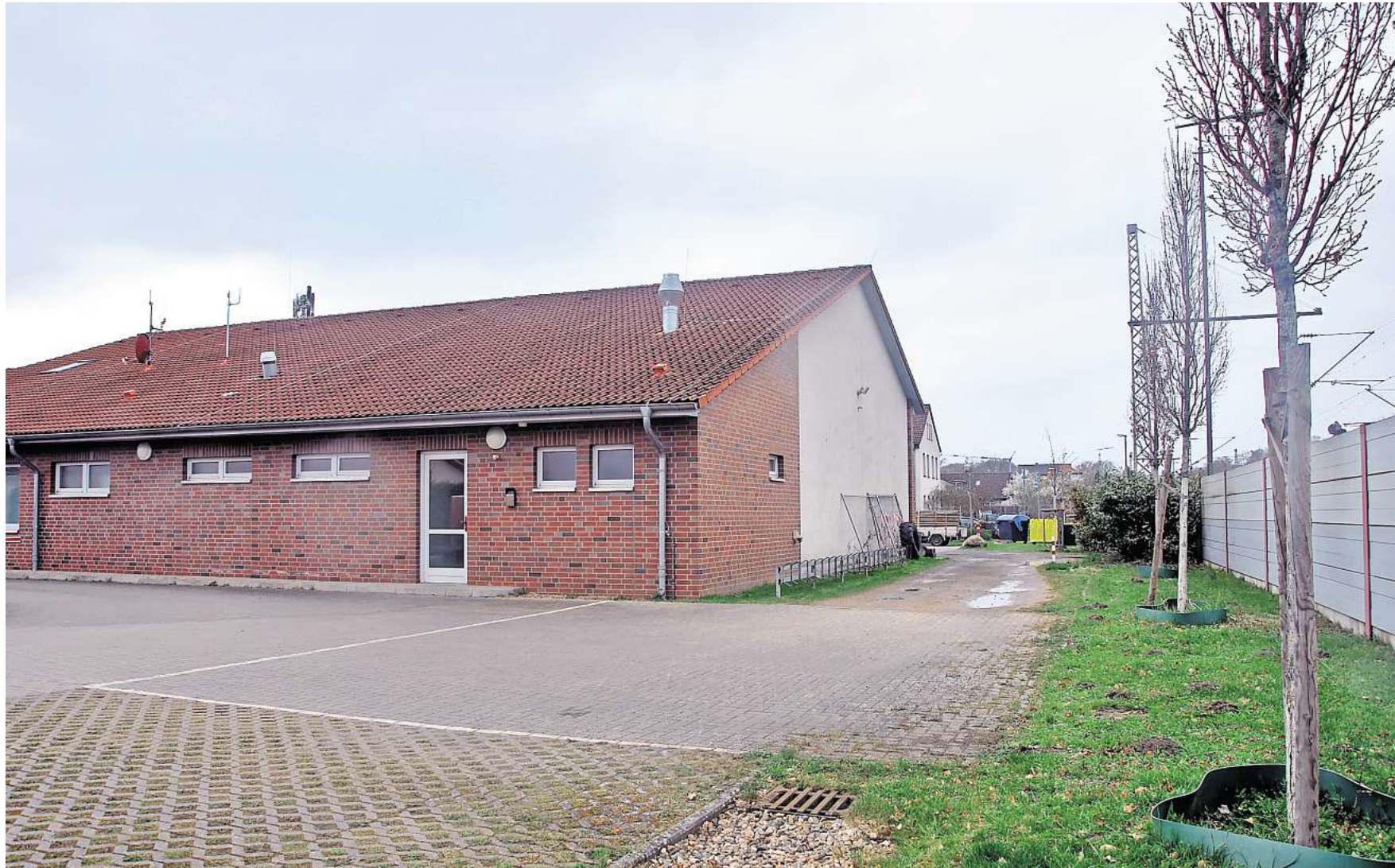
Erweiterung: Der geplante Anbau entsteht auf dem Parkplatz hinter dem Feuerwehrgerätehaus und dockt direkt an dieses an.
