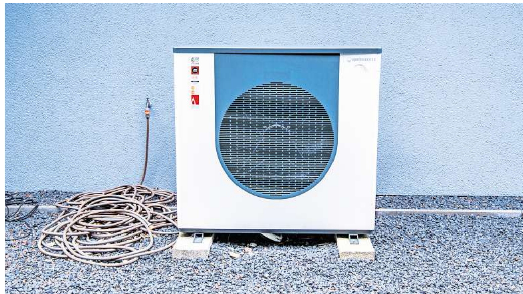
Moderne Wärmepumpen sind leiser als früher: Mit unter 50 Dezibel arbeiten sie so leise wie ein Geschirrspüler.
