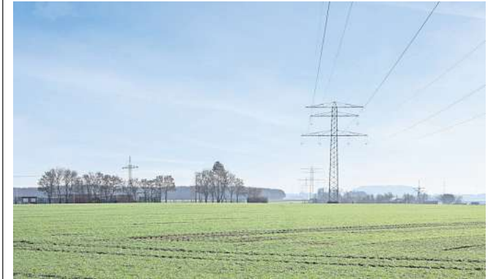
Die TenneT-Bestandsleitung zwischen Lehrte und Mehrum soll erneuert werden. Bis einschließlich 02.03.2026 sind die Planunterlagen für die Öffentlichkeit einsehbar. TenneT
