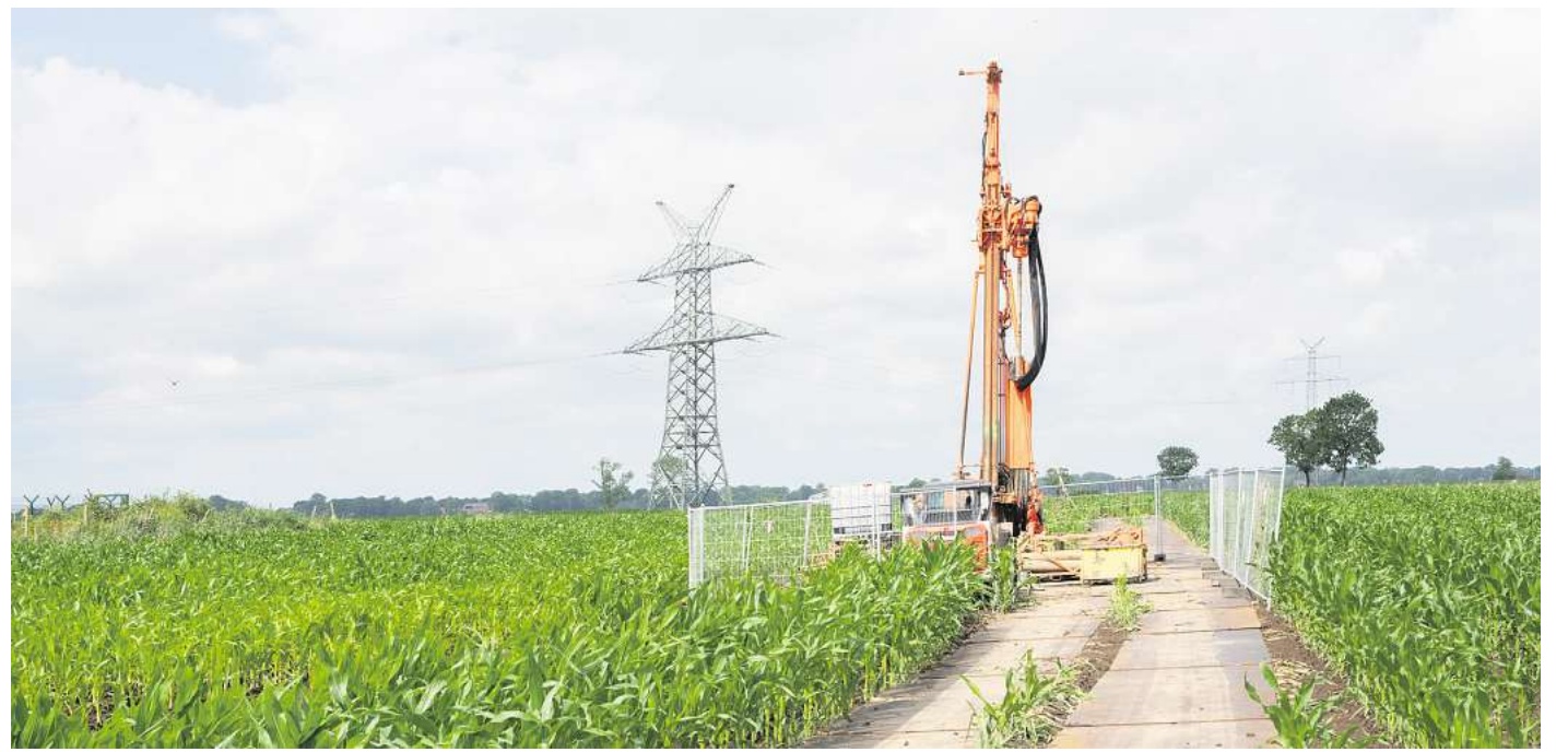
TenneT beginnt mit der Baugrund-Untersuchung.
