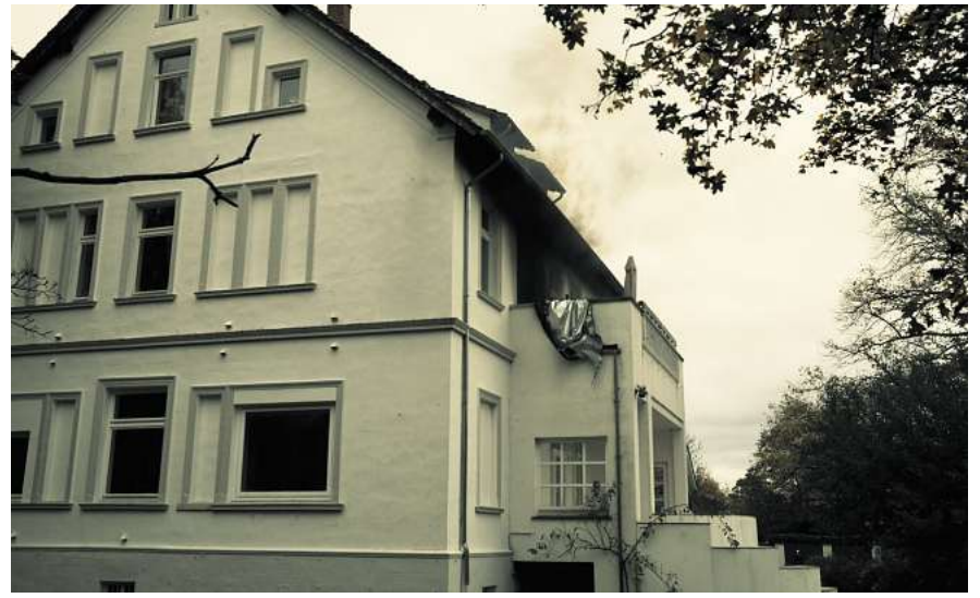
Einsatz der Ortsfeuerwehr: Rauchentwicklung an der Gebäuderückseite an der Sängergasse. Foto: Nico Tschierch
