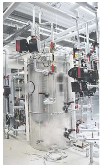
Dank der neuen Kühlanlage kann die Abwärme für Heizung und Warmwasser genutzt werden.
