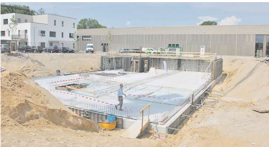
Die Bodenplatte des neuen Büro- und Ärztehauses liegt bereits. Im Hintergrund ist das fast fertige E-Center zu sehen.
