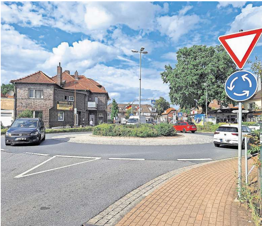
Europakreisler in Uetze: Hier haben sich 2025 gleich mehrere Unfälle ereignet. Foto: Jakob Buddenbohm
