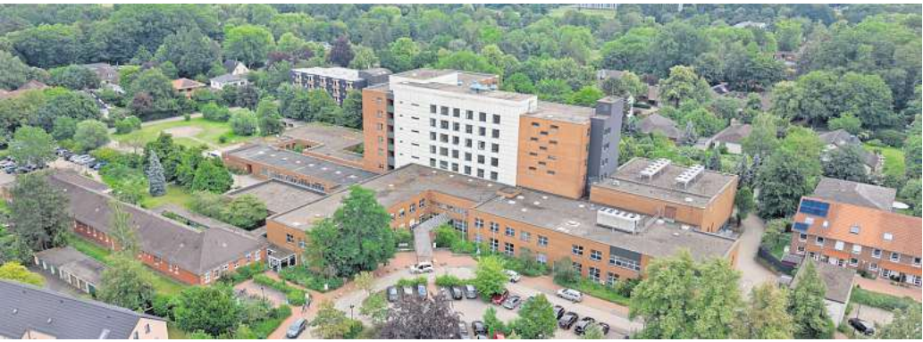
Sanierung und Neubau: Die Hahne-Gruppe möchte auf dem Lehrter Krankenhausgelände die Bestandsgebäude erhalten und verschiedenste Pflegeangebote integrieren. Ein wichtiger Bestandteil des Konzeptes ist auch der Neubau des RGZ durch das KRH auf dem Gelände. Foto: Tim Schaarschmidt
