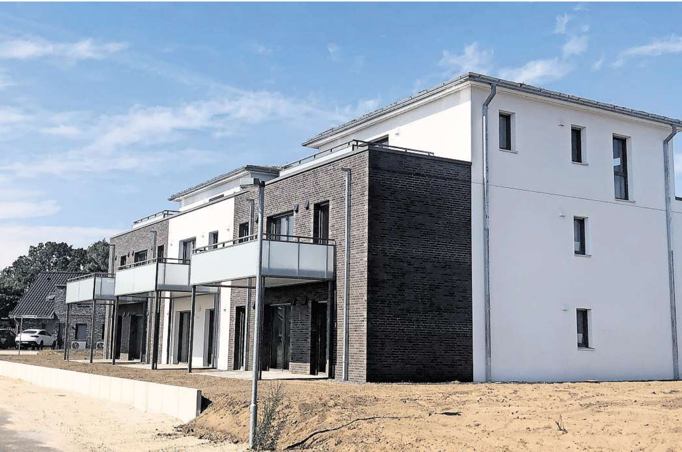
Mietwohnungen in der Nähe des Golfplatzes. Das erste Mehrfamilienhaus im Neubaugebiet Ehlershäuser Weg bietet acht Apartments. Foto: Patricia Oswald-Kipper
