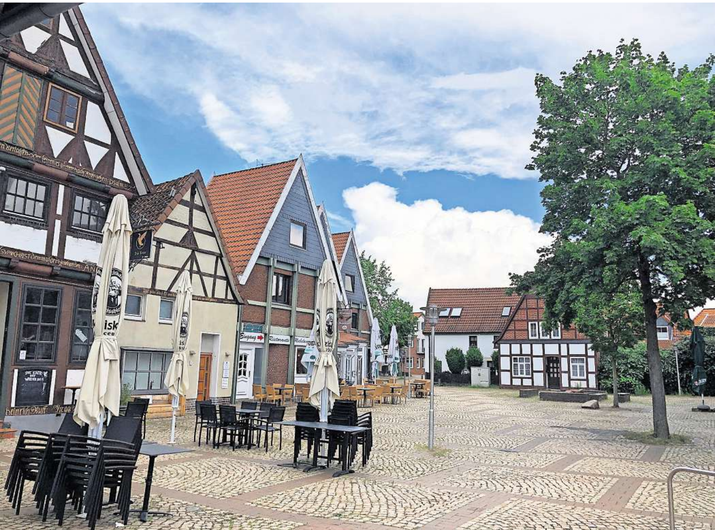
Tagsüber weitgehend leer: Der Platz am Brandende liegt versteckt nur wenige Meter von der Marktstraße entfernt. Auf beiden Seiten gibt es dort Lokale mit Außensitzplätzen.
