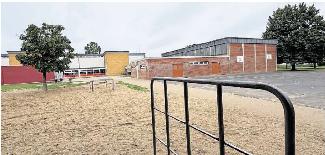
Mit dem Abriss der Turnhalle soll der Neubau beginnen: Die Gemeinde Uetze investiert gut 40 Millionen Euro in die Grundschule am Katenser Weg.
