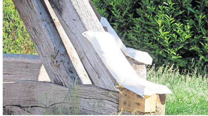
Das Corpus delicti: Anstückeln und Ausbessern verhilft dem maroden Balkenkopf der Kreuzstrebe nicht zur erforderlichen Stabilität. Foto: Martin Lauber
