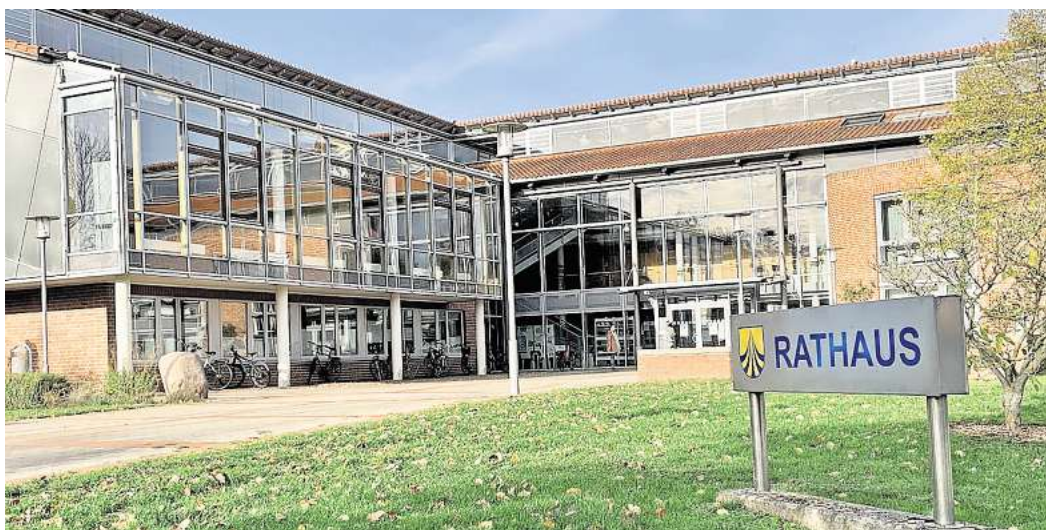
Uetze droht angesichts der Finanzmisere über kurz oder lang eine Überschuldung.
