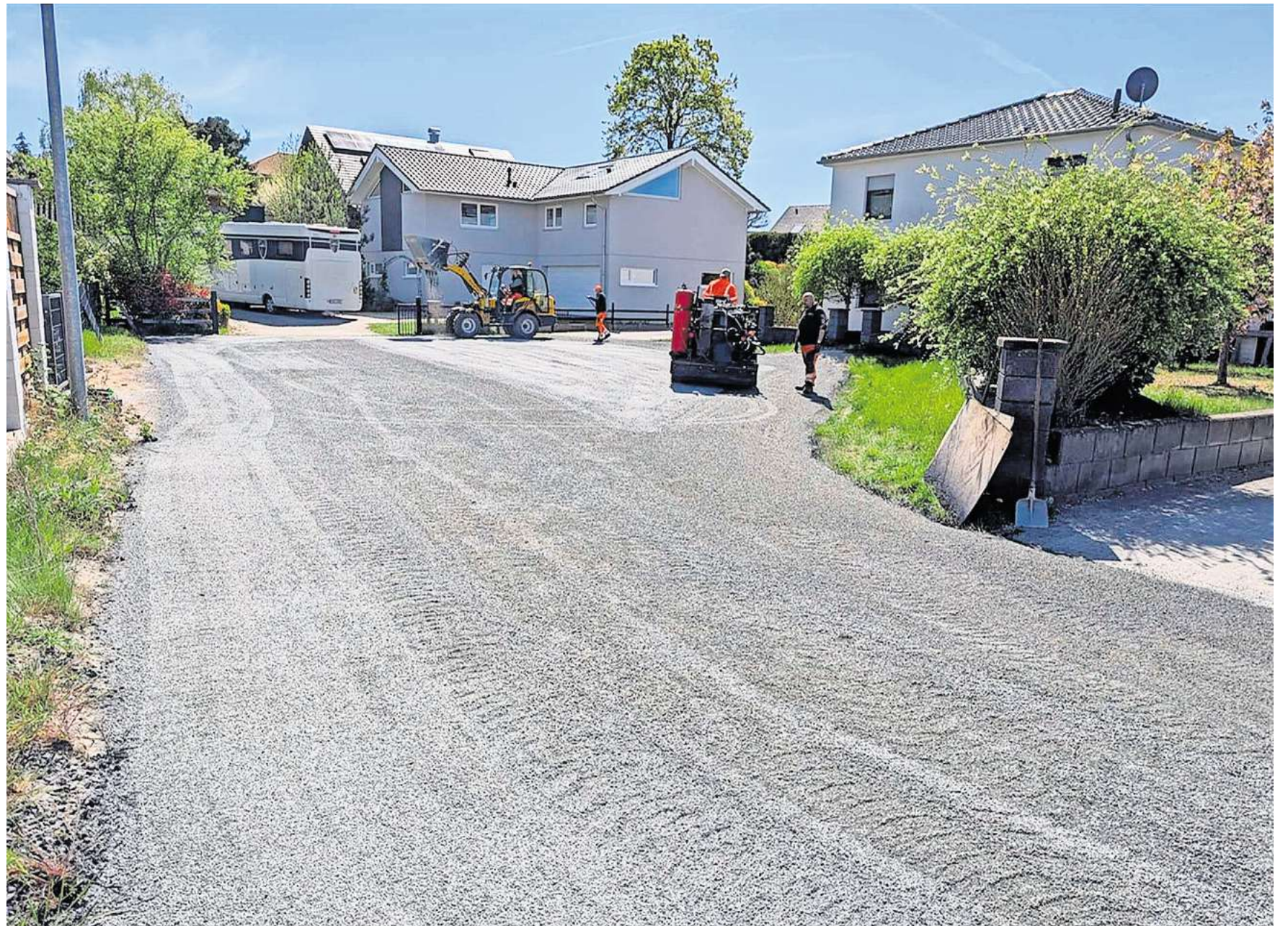
Die Gemeinde hat den Mauerseglerweg saniert.
