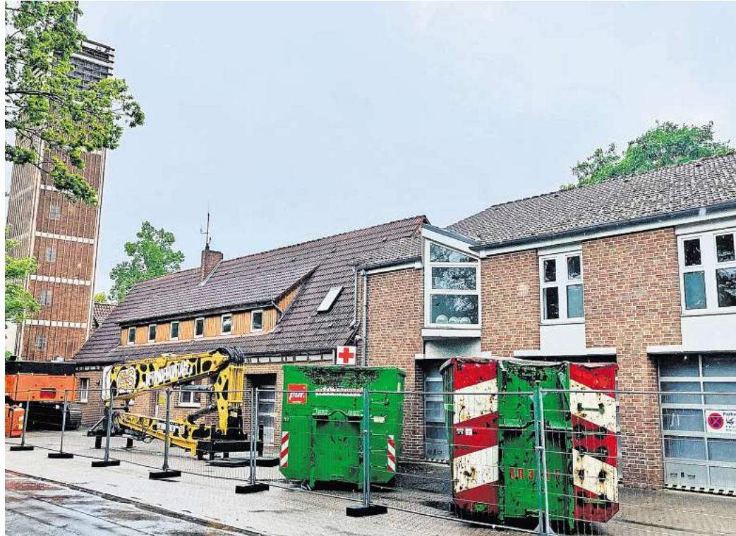
Bevor auf dem Gelände der ehemaligen Feuerwehrtechnischen Zentrale und der Rettungswache ein Neubau entstehen kann, müssen die alten Gebäude abgerissen werden. Foto: Patricia Oswald-Kipper
