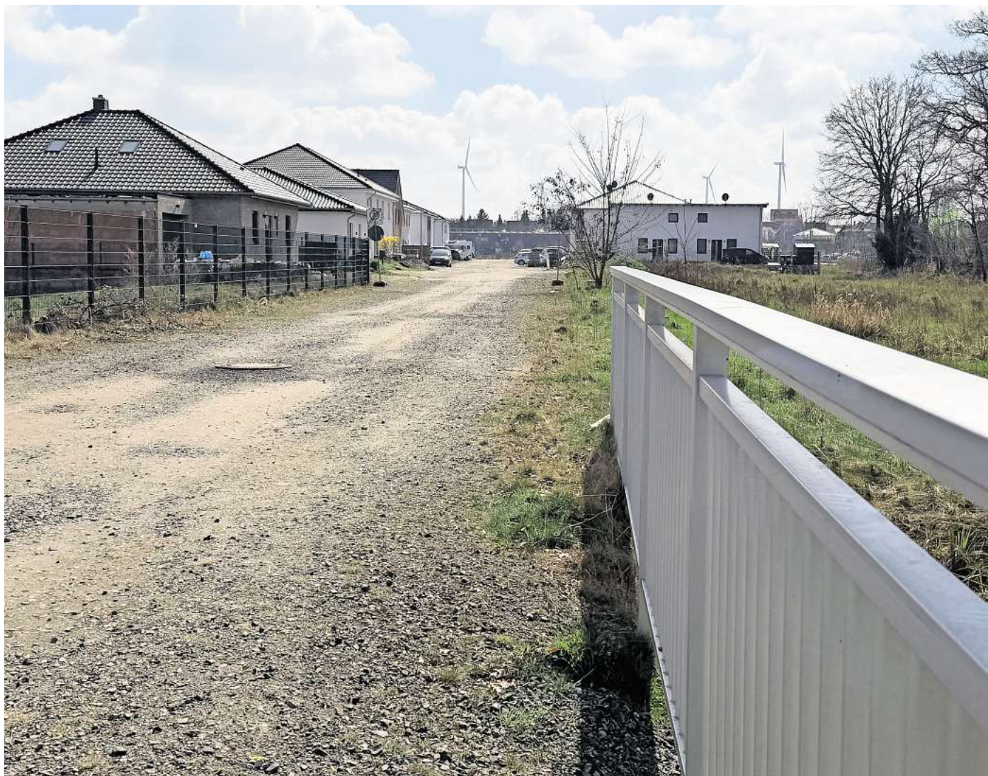
Leben mit dem Provisorium und nassen Füßen: Der Endausbau des Bienenwegs soll noch in diesem Jahr in Angriff genommen werden. Dafür hat der Gemeinderat jetzt grünes Licht gegeben. Foto: Sven Warnecke
