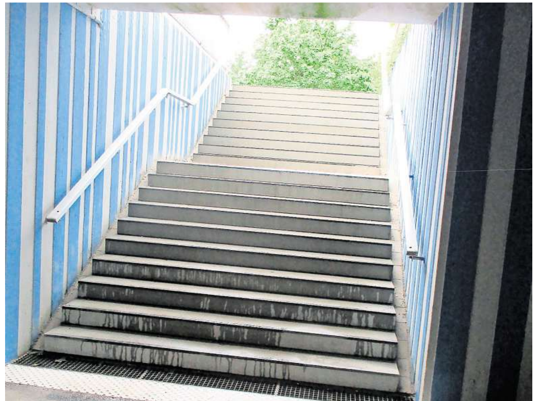
Die Bahnhofstreppe ist wieder freigegeben.
