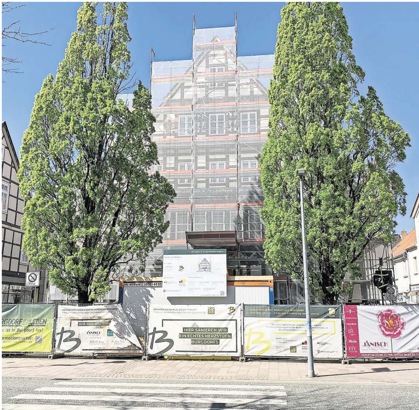
Nutzung als Bürgerhaus: Nach der Sanierung soll das Rathaus I an der Marktstraße für jede und jeden zugänglich sein. Foto: Thea Ball
