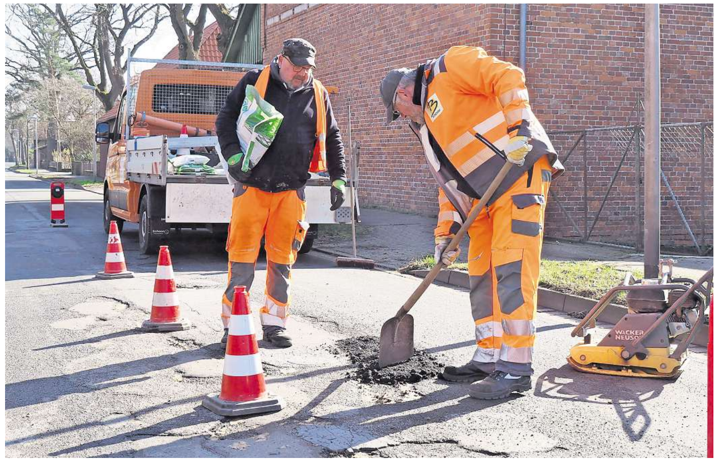
Teamarbeit: Uwe Mohrlüder (links) und Peter Fink bessern gemeinsam ein Schlagloch auf der Worthstraße in Otze aus. Thea Ball
