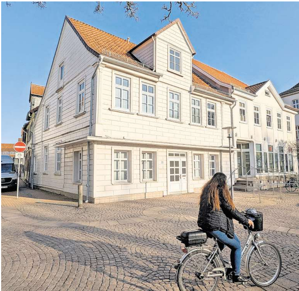
Leerstand am Spittaplatz - aber nicht mehr lange: Zwei Investoren aus Burgdorf haben die komplette Immobilie gekauft und haben große Pläne damit. Foto: Martin Lauber
